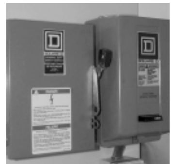
Figura S: 9-1 Interruptor para las máquinas con la opción refrigerante interior del husillo .
